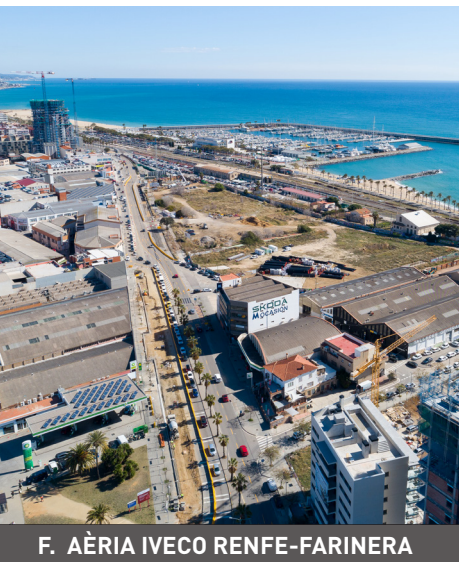
F. AÈRIA IVECO RENFE-FARINERA
