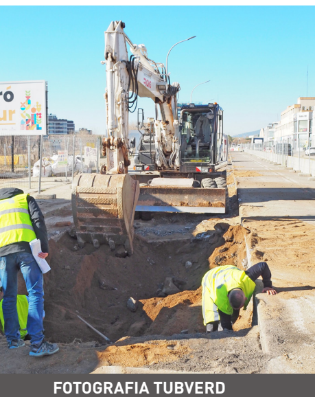
F. AÈRIA IVECO RENFE-FARINERA
